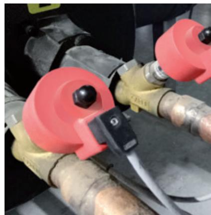
Встроенные электронные расширительные вентили в каждом контуре
