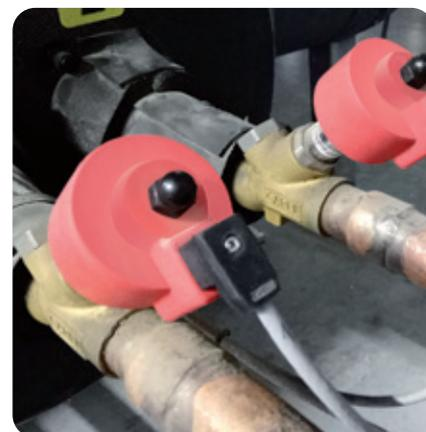
Встроенные электронные расширительные вентили в каждом контуре
